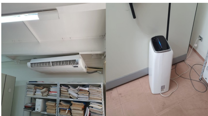
Figura 4. Ar Condicionado Split Marca Rheem - modelo RB1PT36HP2BC 36.000 BTU à direita e Desumidificador de Ar Desidrät Max 500 - 127v, à esquerda, localizados na Área 01: Área de tratamento documental e armário deslizante.
