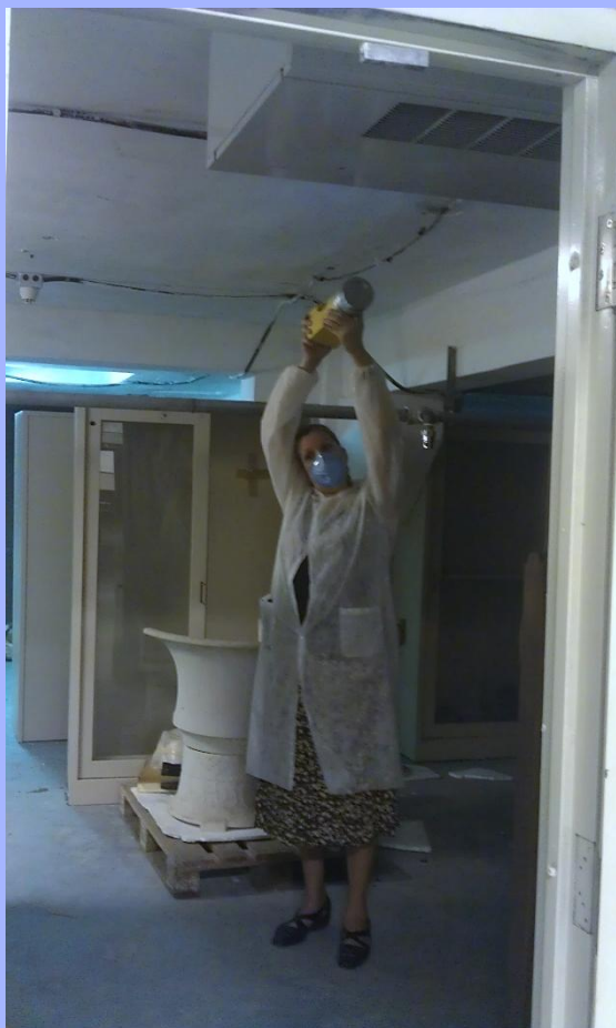
Figura 6. El biocolelector debe colocarse de frente a la salida del aire que expulsa el acondicionador de aire al interior del espacio en estudio.
